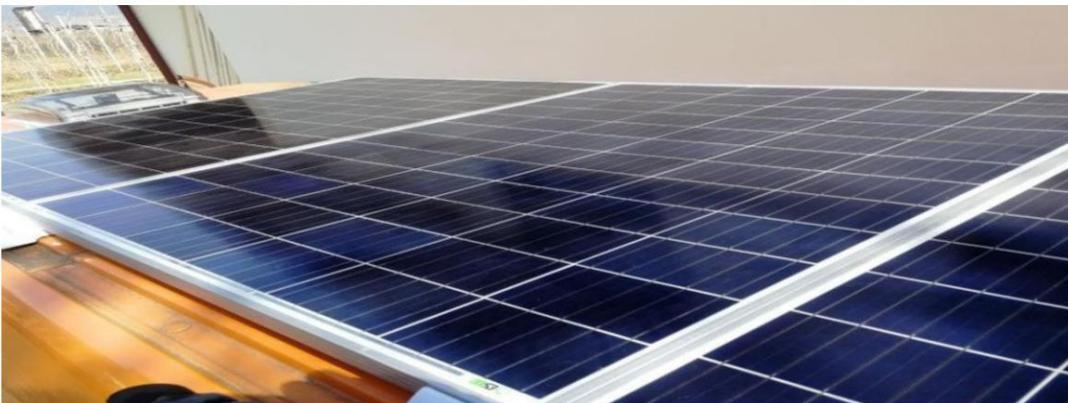
¡No atornille las esquinas del spoiler al módulo solar antes del montaje, ya que de lo contrario ya no podrá compensar los desniveles! (Si el tejado es completamente plano, las esquinas de montaje también se pueden atornillar al módulo solar antes de pegarlo, esto es más fácil, pero se puede compensar con menos).
