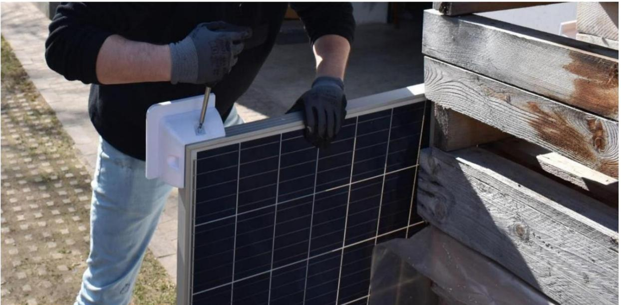
No se recomienda el uso de tornillos con pernos porque una vez pegados los soportes ya no se pueden retirar los paneles (ni siquiera para mantenimiento).
