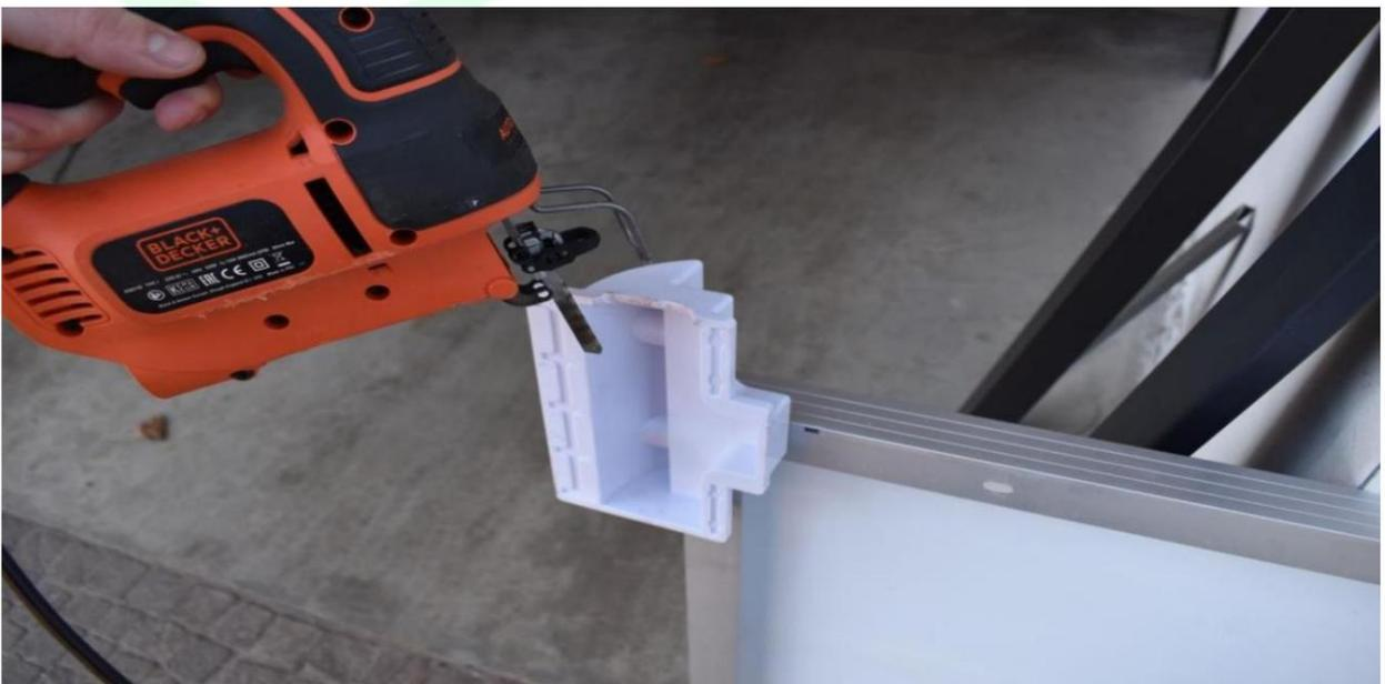
Pruebe los paneles nuevamente en el techo hasta que los soportes asiente firmemente en las ranuras. Puedes hacer uno con una lima manual.
