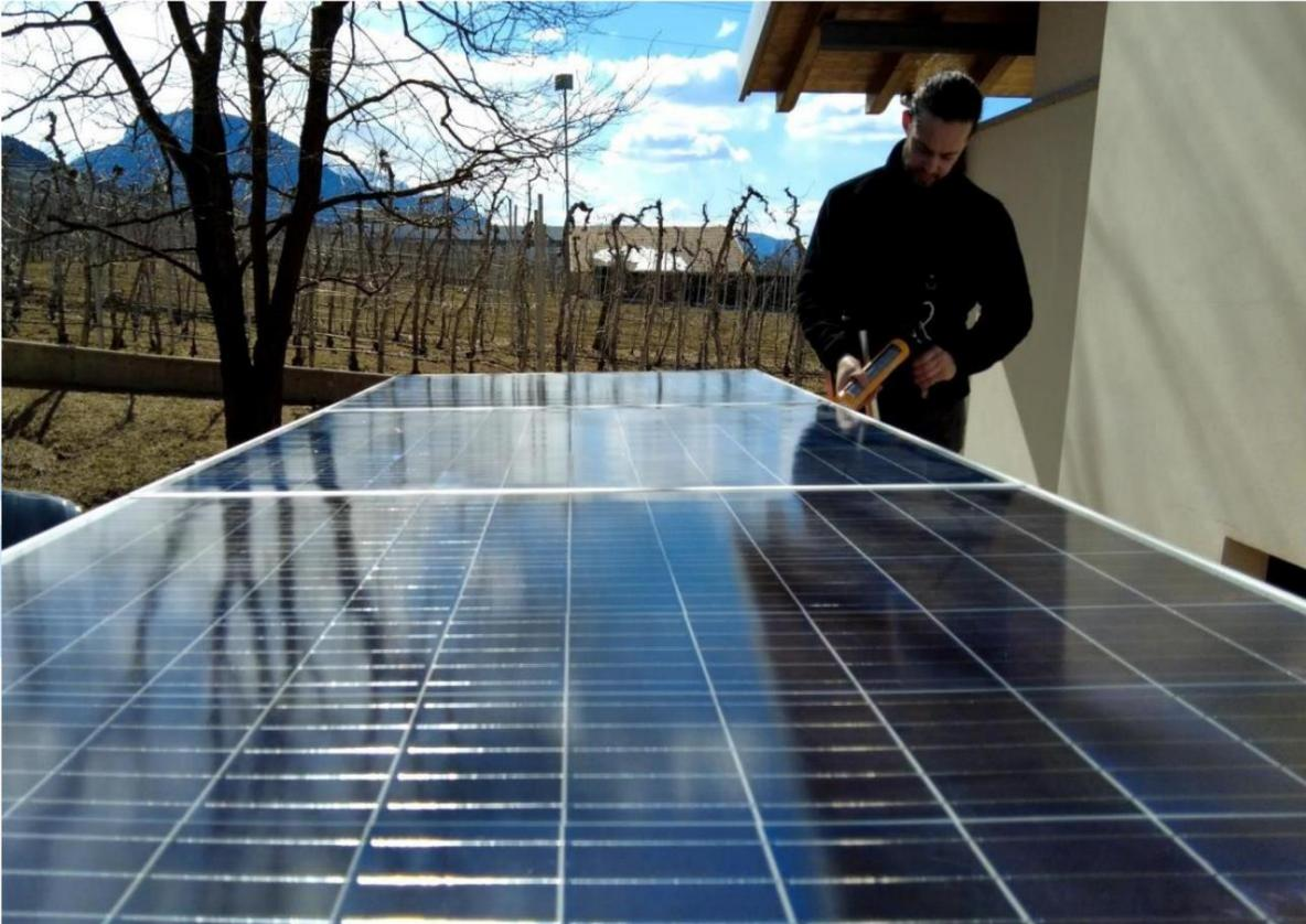
Cuando el pegamento se haya secado, los ángulos y las Los módulos solares están firmemente anclados al techo de tu furgoneta y estable como piedra. Después de aproximadamente 48 horas puedes Ya estoy seguro de que puedes conducir sin pensar en que se salgan.
